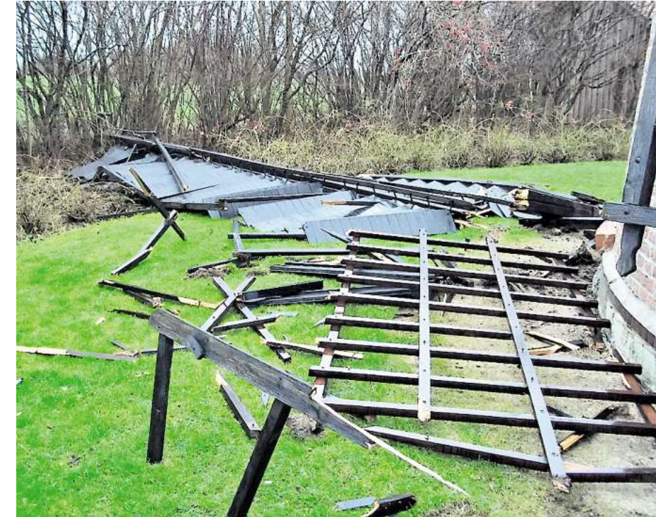
Der zerstörte Mühlenflügel liegt am Boden neben der Anlage.
