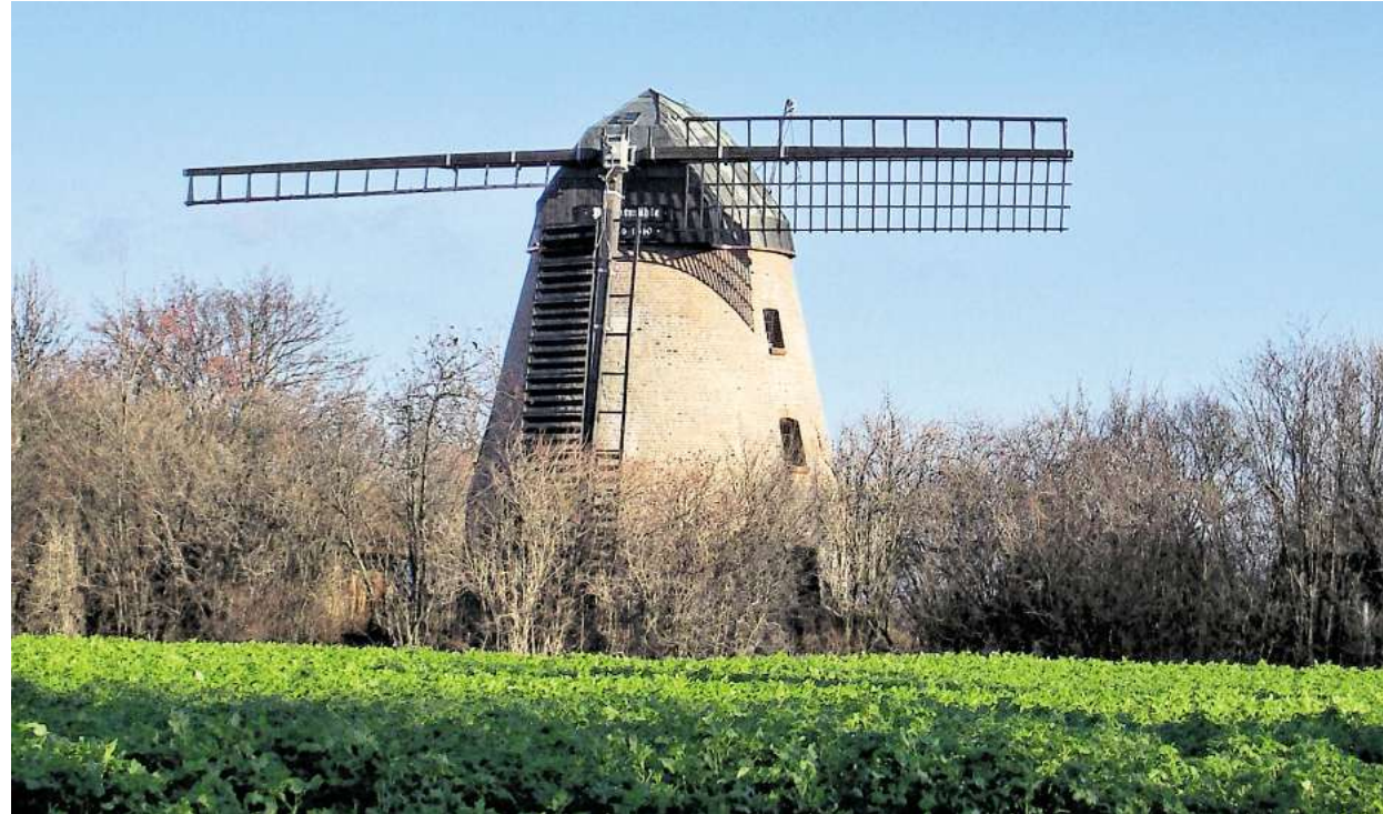
Da fehlt etwas: Einer der Rotorflügel der Söhlde Patentmühle ist einem Sturm zum Opfer gefallen.
